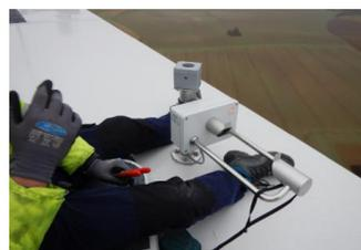
**Légende** : Capteurs luminosité et précipitation
